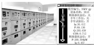
图 11 某矿变电所内开关柜运行状态监测截图
