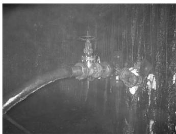
图6 22413回风巷清污分离管路安装
