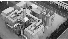
(a) 3 MW 级天然气 MCFC 发电系统
